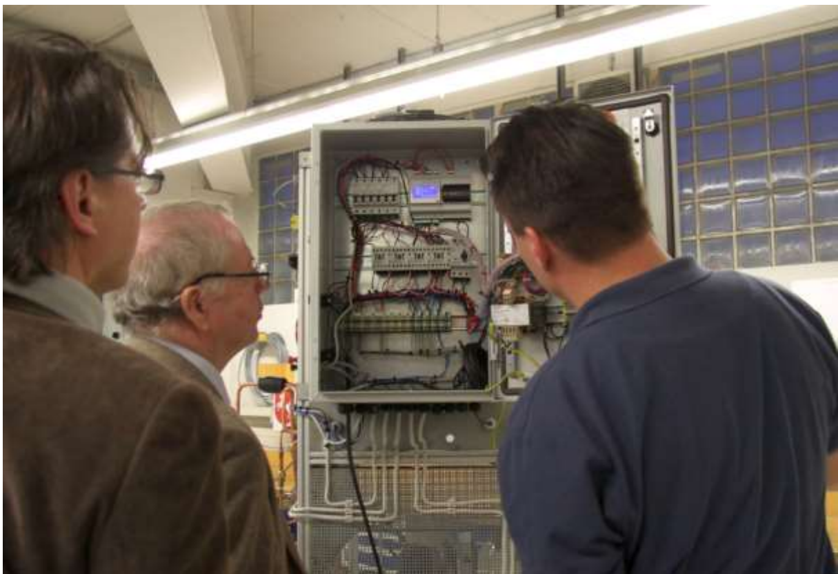
Ein Blick in den Schaltschrank: Helmut Lauterbach von Glen Dimplex präsentiert die Wettbewerbsanlagen. / Quelle: Marlene Klocke
